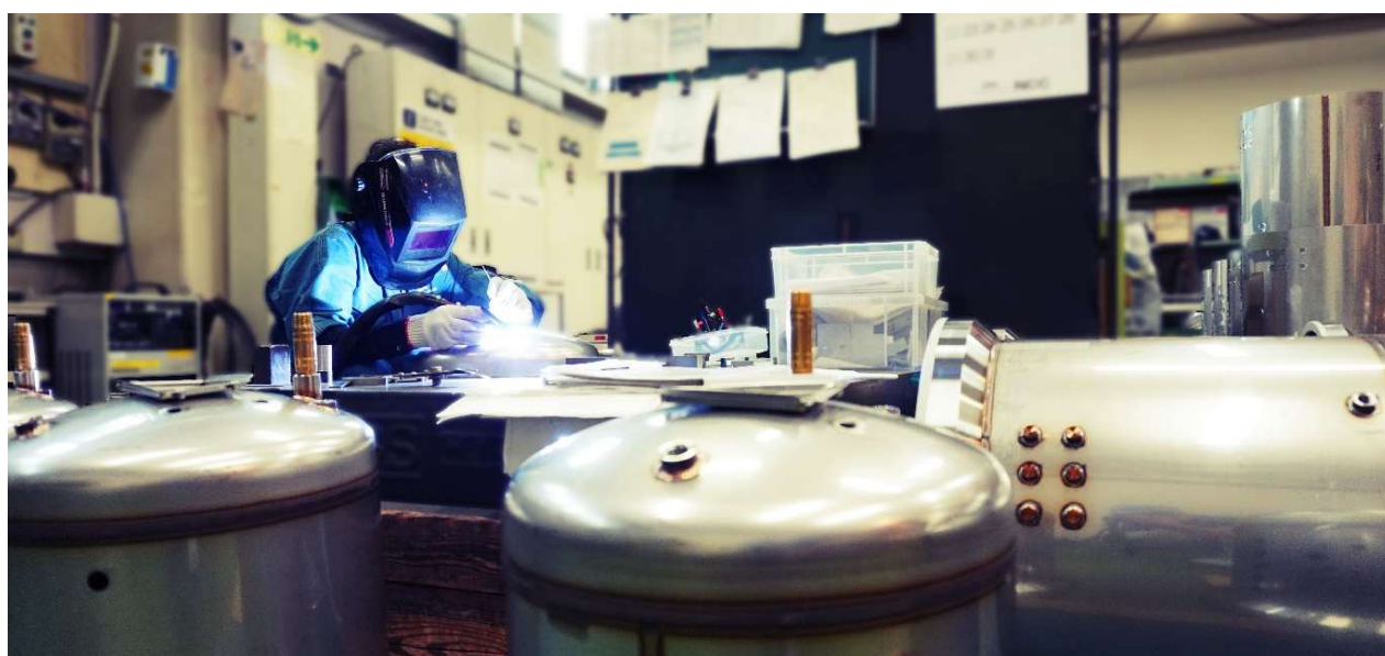
圧力容器製造の様子
